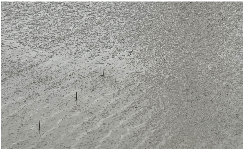
Nach dem Betonieren bleibt ein Teil der Abdeckung sichtbar. Bildquelle: Züblin.
