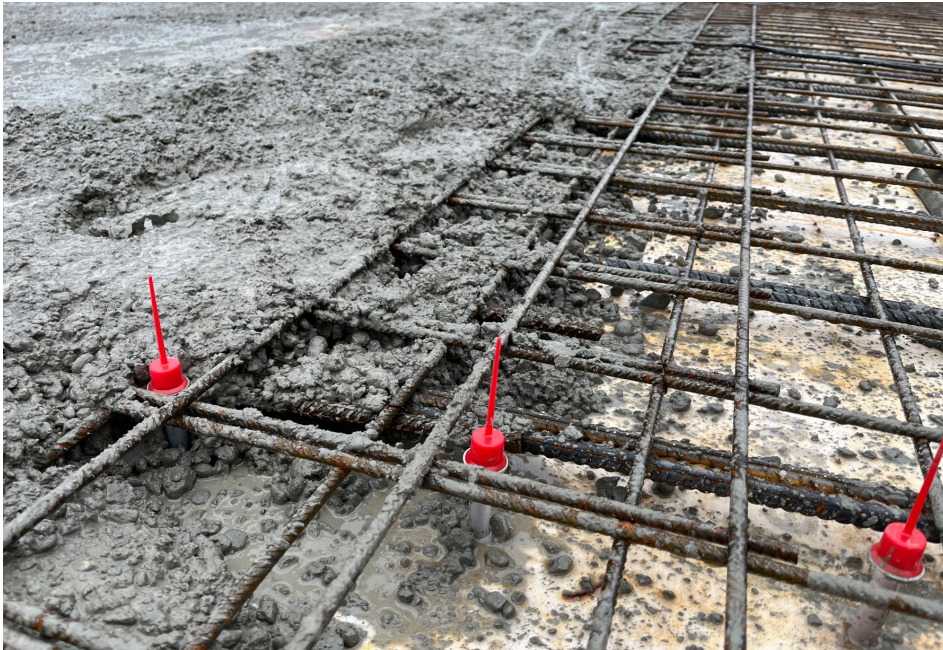
Vor dem Betonieren – Der KVB-Verbinder wurde mit einer innovativen Abdeckung versehen. Bildquelle: Züblin.
